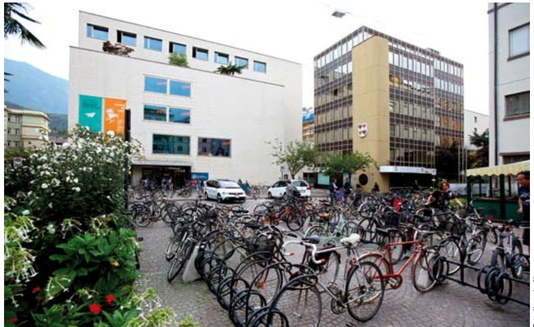
Die Uni Bozen (links) samt Gebäude der Region (rechts): Daraus soll das „Haus der Studenten“ werden.
